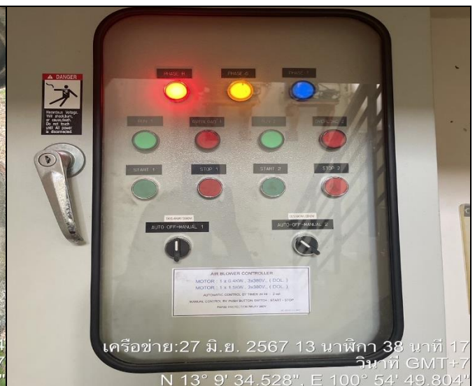
รูปที่ 2.4.3.3 - 2 ตู้ควบคุมระบบบำบัดน้ำเสีย
