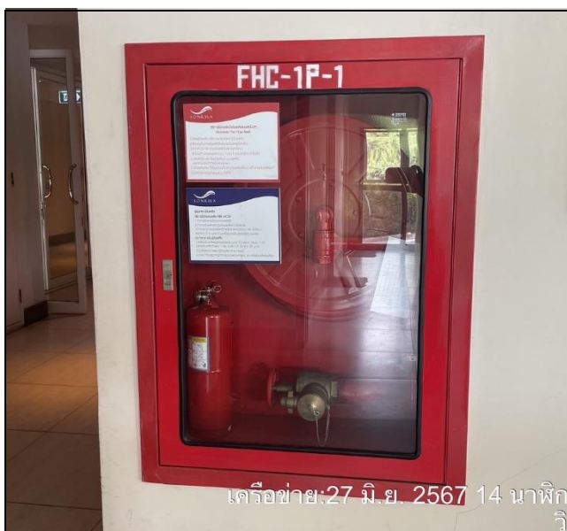
รูปที่ 2.4.7.3-1 ตู้เก็บสายฉีดน้ำดับเพลิงพร้อมอุปกรณ์
